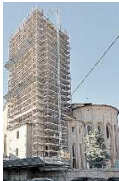
CANTIERE La chiesa di San Nicolò
