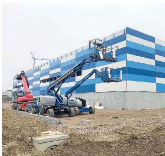
Il cantiere per il grande polo logistico Toyota Tsusho a Casier
