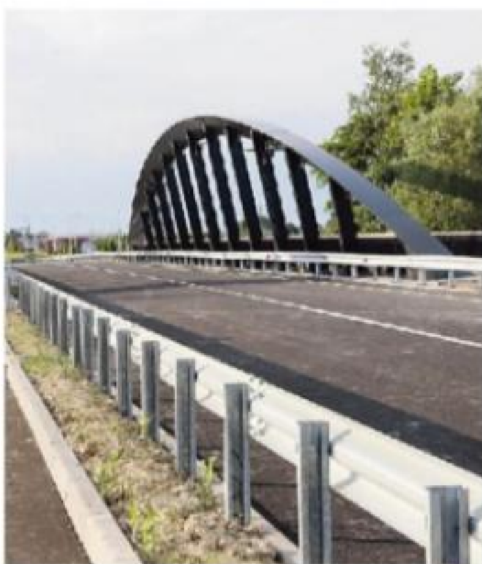
Il tratto costruito del Terraglio Est termina a Casier
