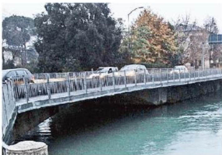
Il ponte Garibaldi, detto anche Dal Negro, uno dei punti chiave del Put
